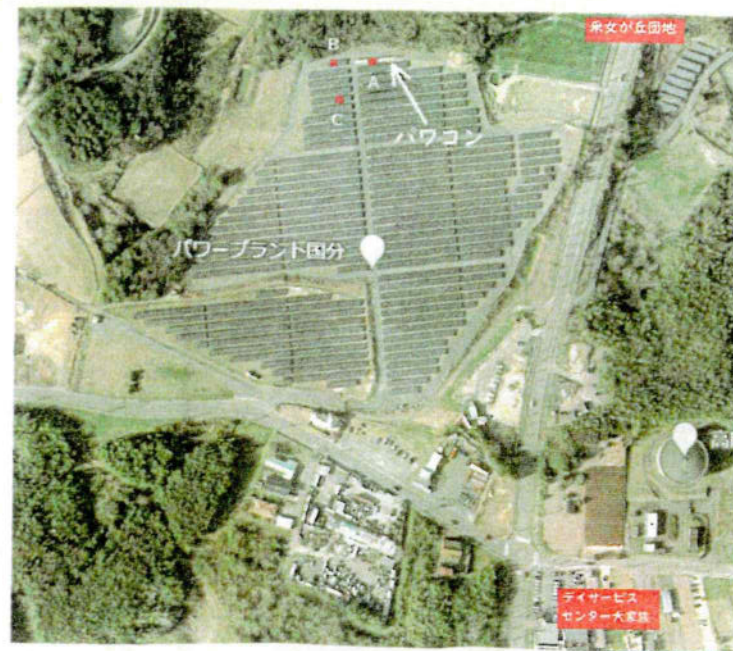
①パワープラント国分発電所の全景
