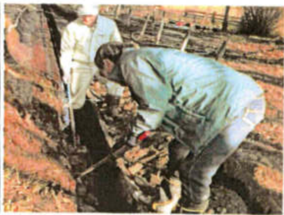
①泥や落葉を取り出し、排水路をきれいに掃除
