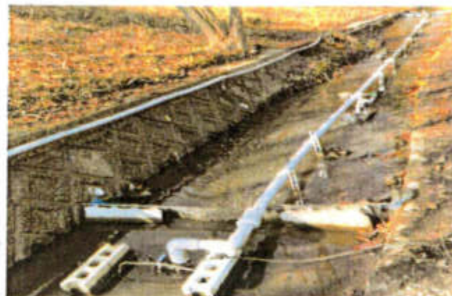
③水の流れを作るために20mの排水管を作る
