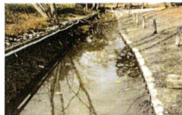
④ブロックを積んで約40mのホタル池を作る
