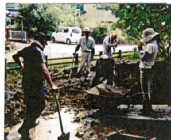
2つ目のトンボ池作り(穴掘り作業)
