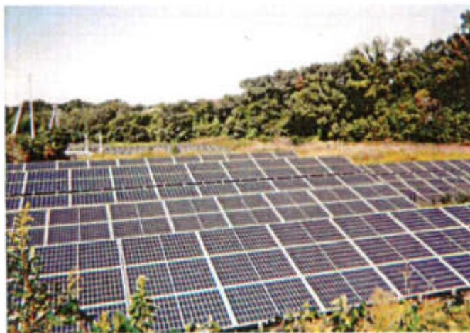
④ 太陽光パネルの設置（采女が丘団地周辺）
