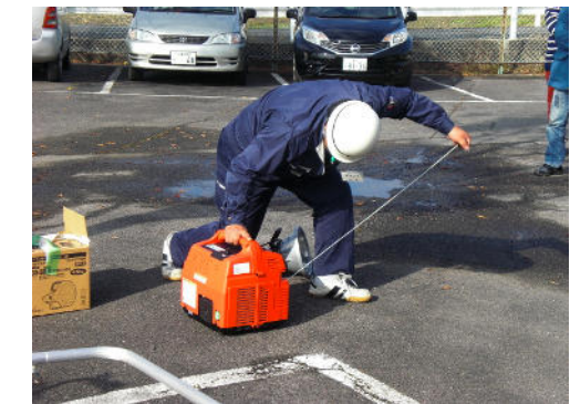
自家発電機操作訓練
