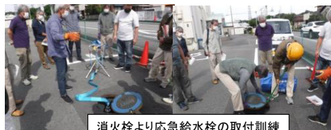
消火栓より応急給水栓の取付訓練
