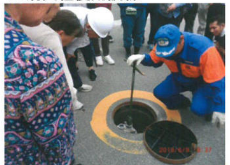
L: 消火栓使用訓練
